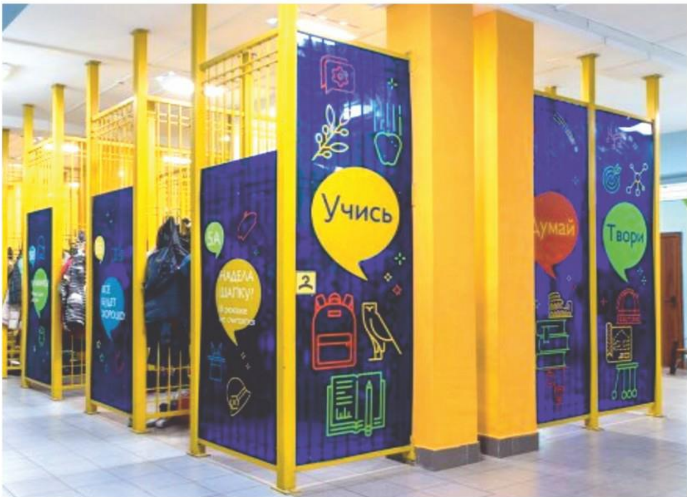
ГАРДЕРОБ ВЫПОЛНЕН В ВИДЕ НЕБОЛЬШИХ КОМНАТ. КАРКАС ИЗ ПРОФИЛЬНОЙ ТРУБЫ, ПАНЕЛИ ИЗ АКРИЛОВОГО СТЕКЛА С НАКЛЕЙКАМИ.
